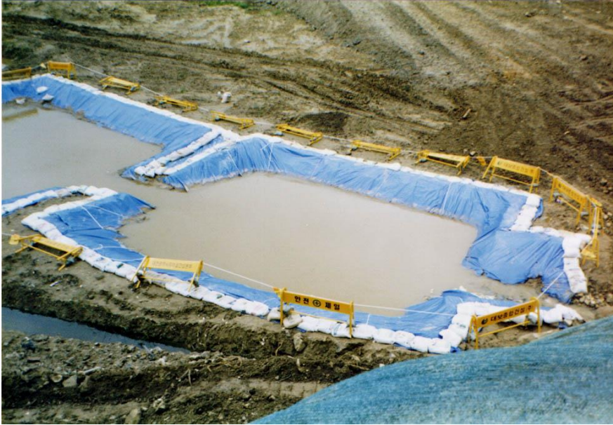
공사 중 임시침사지
