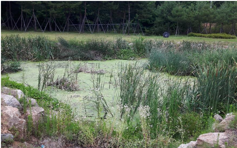
저류시설 내 녹조 발생 및 고사체 미제거
